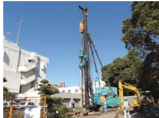
大型機を用いた施工(集会所)
